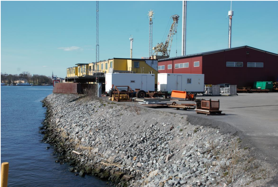
Figur 9. Strandlinjen för kajkonstruktion består nu av sprängstenslänter.
