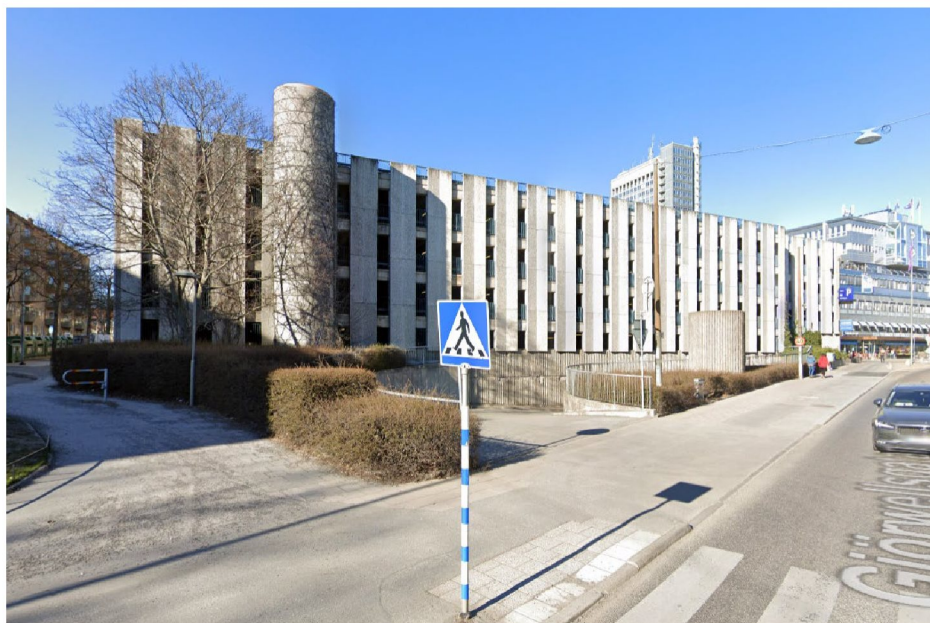
Trängkåren 7 - Befintligt parkeringshus. Bildkälla: Google street view
