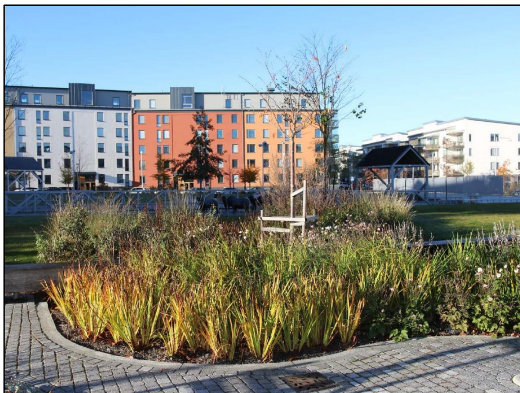
Figur 18. Exempel på nedsänkt växtbädd (Solna stad dagvattenstrategi, 2017)
