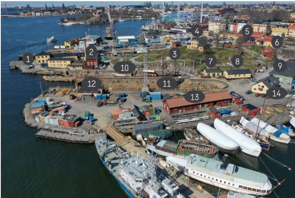
Figur 3. Byggnader och funktioner på Beckholmens östra sida. 1. Pumphus och pannhus, 2. Bostadshus 512, 3. Ateljén, 4. Stenvillan, 5. Hus 505, 6. Tjärmästarbostaden, 7. Smedjan, 8. Klockhuset, 9. Wasakonserveringen, 10. Västra dockan, 11. Östra dockan, 12. Lilla pumphuset, 13. Stöttboden, 14. Radarskolan. Foto: Sweco, 2021.
