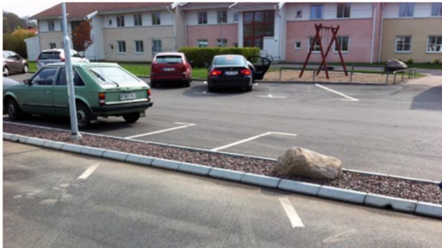
Figur 9. Makadamdike som tar emot avrinning av dagvatten från parkeringsyta. 17
