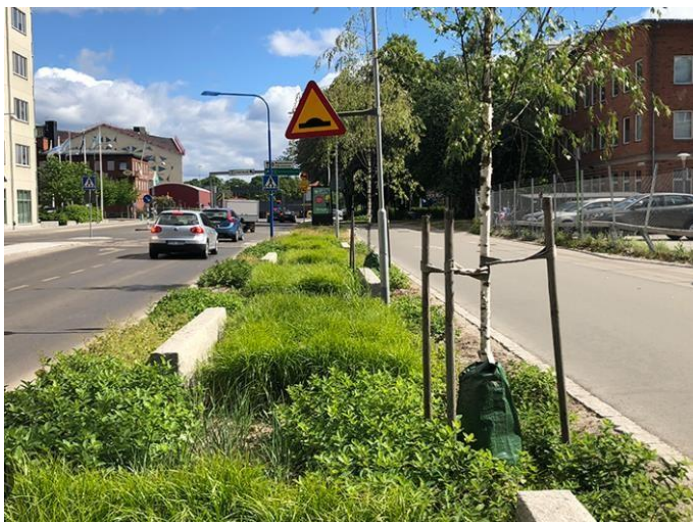
Figur 16. Exempel på utförande av regnväxtbädd.
