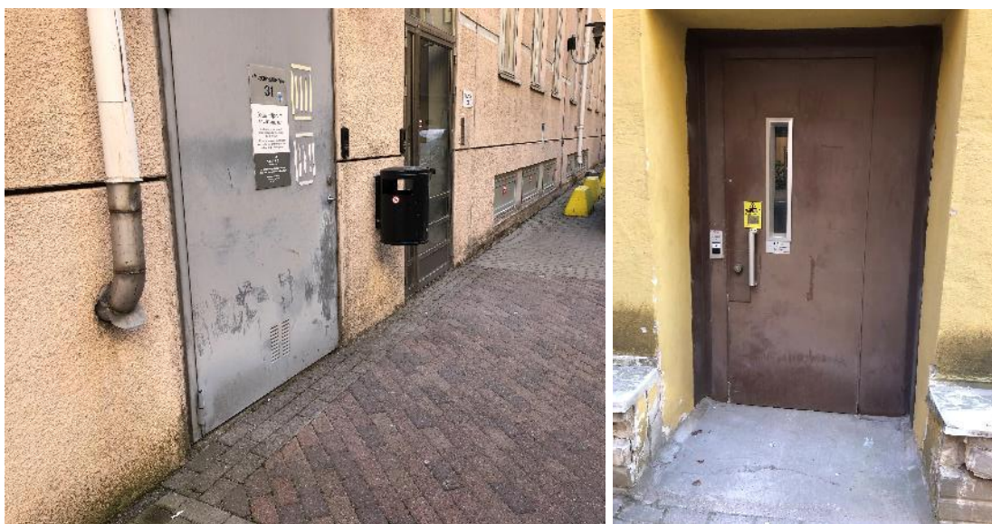
Figur 3. Längs med lastfaret finns dörrar i marknivå till byggnader både inom och utanför planområdet (exempelvis en hiss i marknivå på högra bilden) och brandluckor till garaget (längst bort i vänstra bilden).
