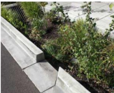
Figur 10. Olika kantstenslösningar för ytligt inlopp till regnbädd.
