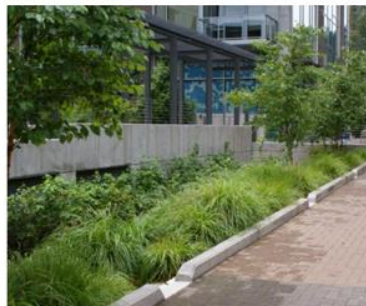
Figur 10. Olika kantstenslösningar för ytligt inlopp till regnbädd.
