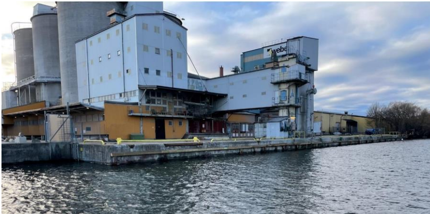
Figur 2-2. Cementakajen och deltaformad brygga med pollare väster om kajen.
