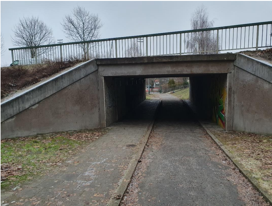
Figur 6: Gång- och cykeltunnel under Hagsätravägen. Foto: Sweco.
