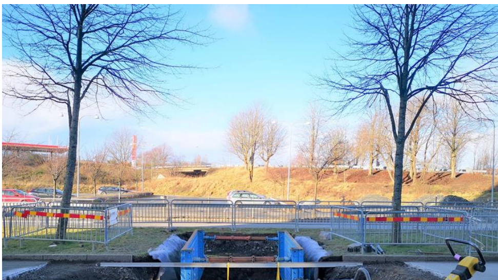
Bild 7. Användandet av spontsläde vid schakt intill träd.
