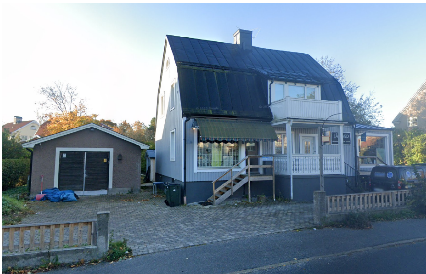
Bilden visar villa med verksamhetslokal och tillhörande komplementbyggnad inom Landsknekten 23. Ett genomförande av planförslaget medför att byggnader inom Landsknekten 23 behöver rivas.
