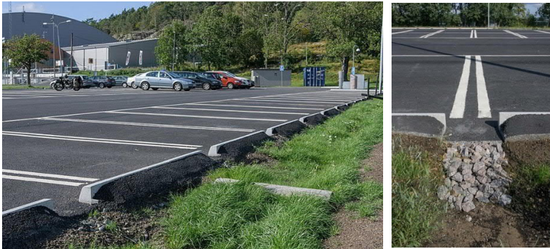
Figur 23. Exempel på utformning av reningslösning från parkeringsyta (Kviberg, Göteborg) Notera erosionsskydd vid kantstenens öppningar. Bildkälla: SMHI (Peter Svensson).
