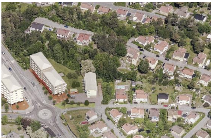
Byggnadernas parallella placering gör att siktlinjen från Hjortronvägen/ Kyrkoherdevägen bevaras till viss del. Andrén Fogelström 2023-12-19
