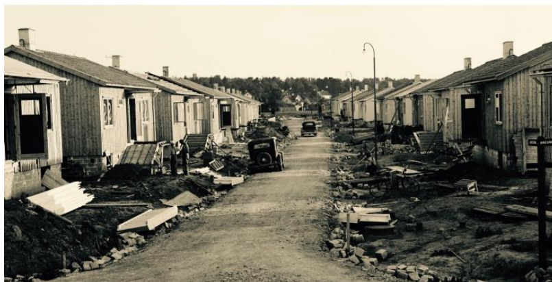
Exempel på småstugebebyggelse under uppförande, bild från Uppsala 1936. Bild Upplandsmuseet.
