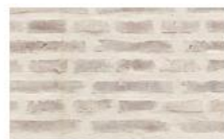
Ytterväggar bottenvåning: ljus tegel säckskurat
