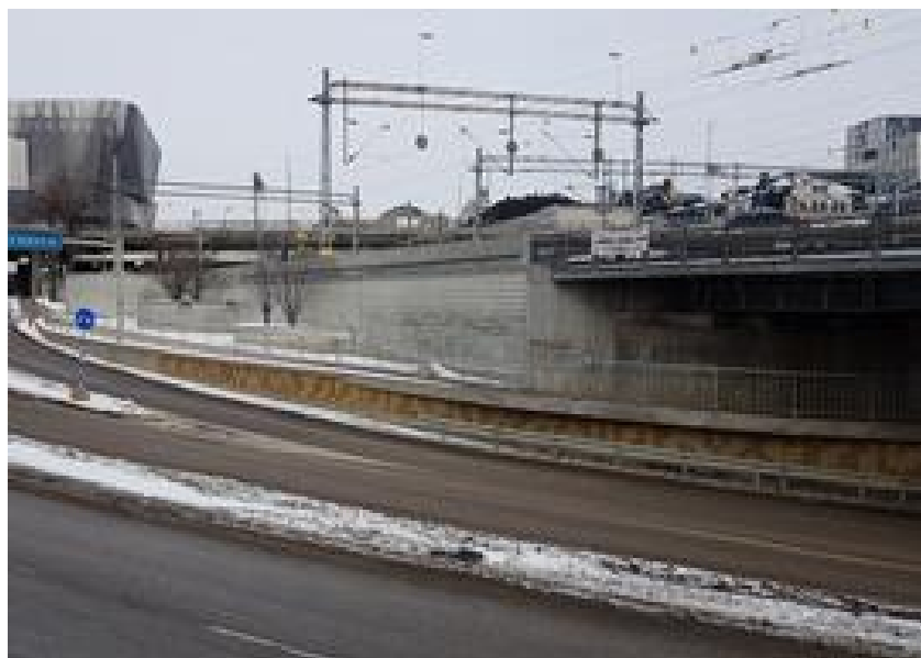
Järnvägsbronns fäste mot norr, med stödmur och planteringar
