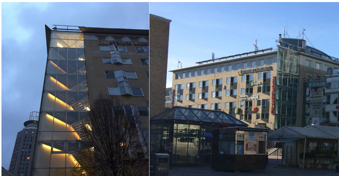
Björkhallens fasad: Fönstren veckas ut i ett litet burspråk som ger djupverkan och släppljus över fasaden. Takfoten är markerad, men bryts av vid de glasade partierna som gör ett diagonalt snitt genom byggnaden och som ger dagsljus in i ljushallen.
