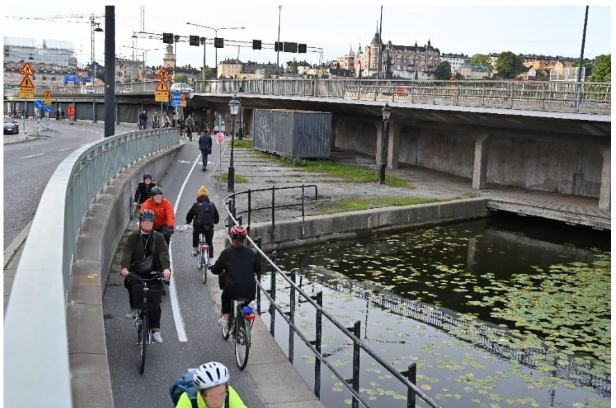
Bild 8. Cykelbana mot Gamla stans tunnelbana
