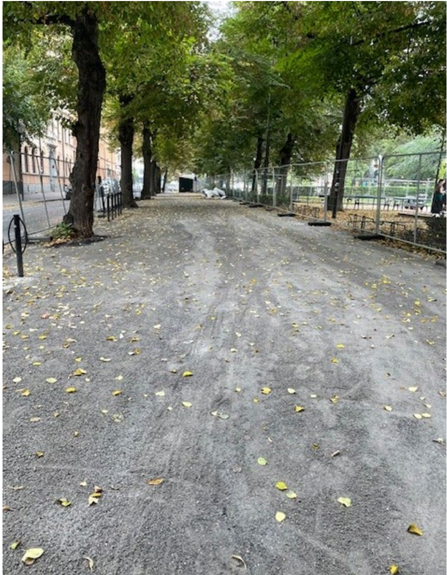
Bilden ovan visar Mariatorgets västra allé som erhållit nytt genomsläppligt material. Foto: Södermalms stadsdelsförvaltning.
