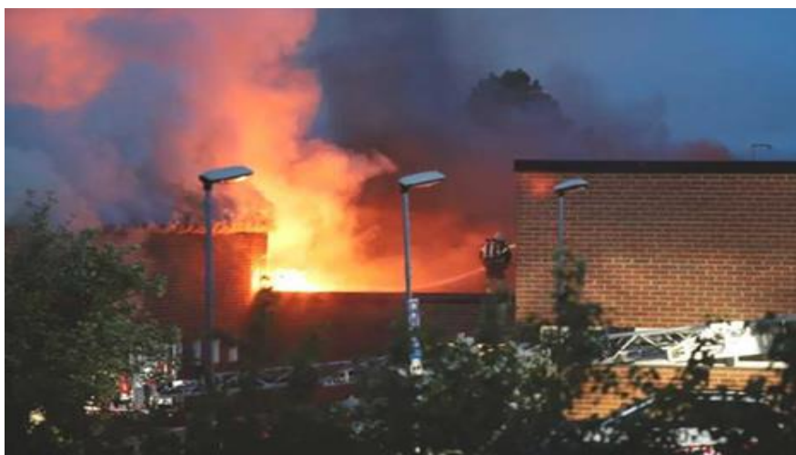
Figur 10 Bilden visar en brand i Slättgårdsskolan som delvis blev totalskadad, och i övrigt skadades av släckvatten, rök och sot.
