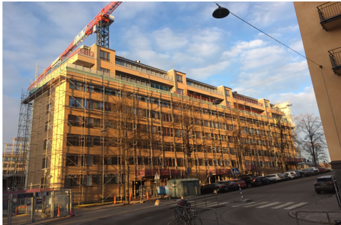
Påbyggnad i två våningar. Etapp 1 av påbyggnaden motsvarande 25 lägenheter.
