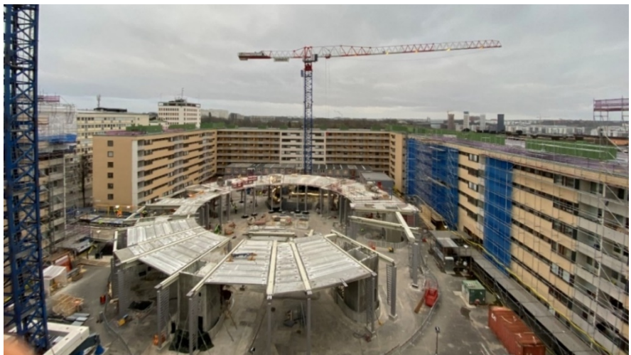
Bild över gårdshuset där uppförandet av stommen är påbörjad.
