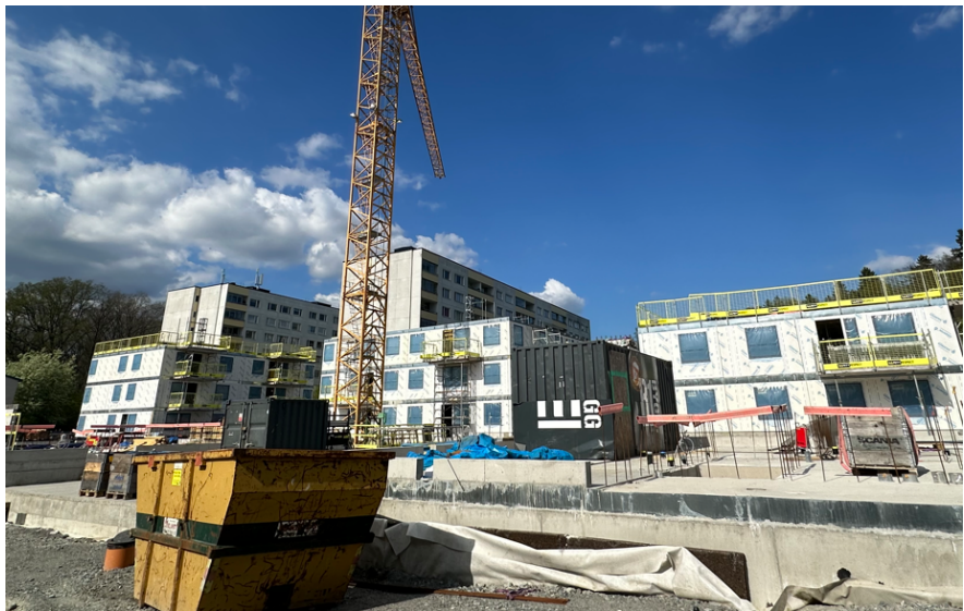
Bild från pågående nyproduktion.
