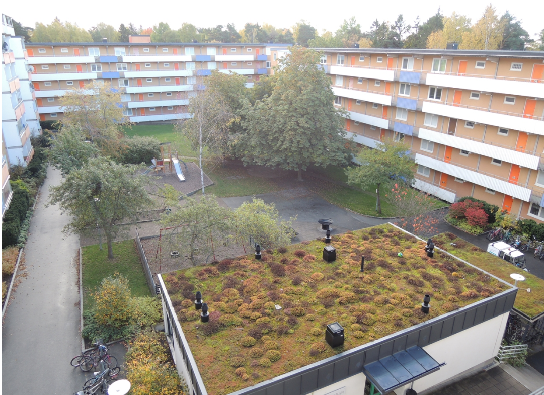
Bild 2. Vy över fastighetens innergård.
