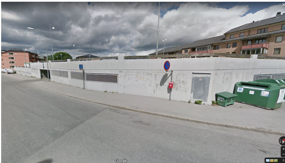
Bild 5. Gatuvy från Åstorpsringen befintlig situation.
