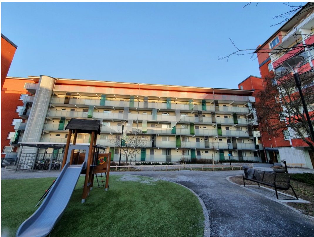
Bild 1. Oslogatan 22 med återuppbyggd påbyggnad efter brand.
