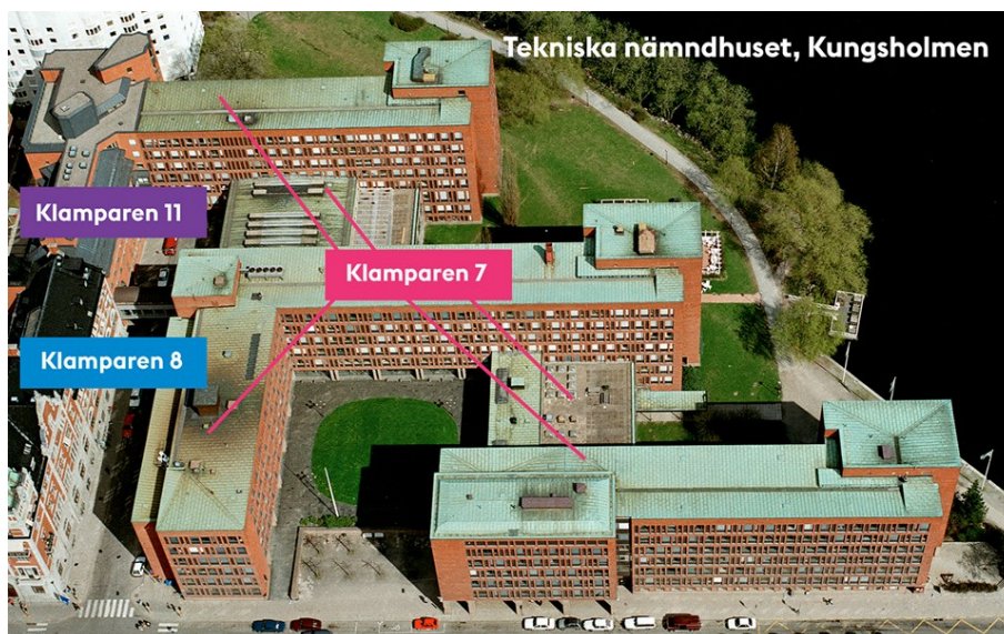
Tekniska nämndhusets olika fastigheter.
