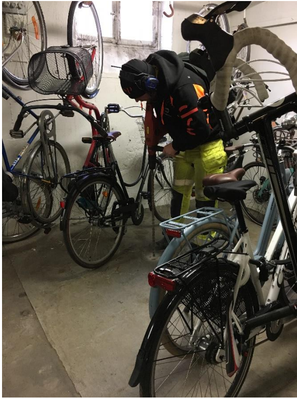
Porluftspunkter i källare vid misstänkt plats för f.d kemtvätt. Borrnas med handhållen borrhammare
